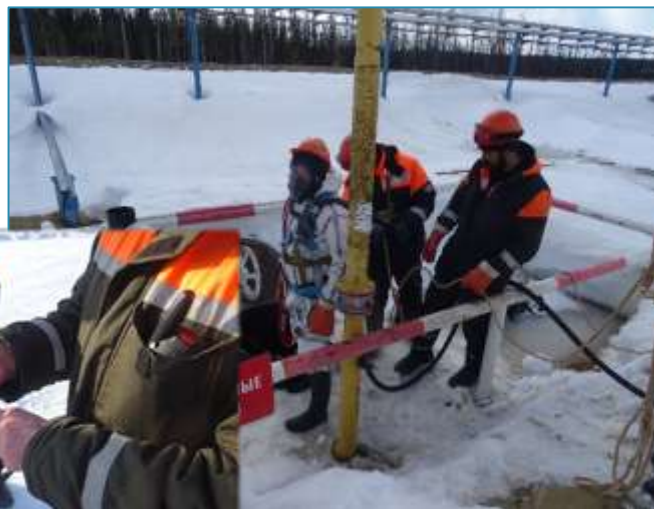
Проведение газоопасных работ
