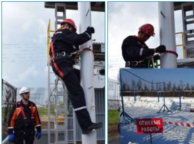
Работы на высоте
