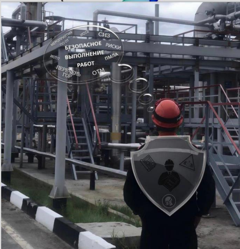
Фоторабота «Мысли о безопасном выполнении работ»
