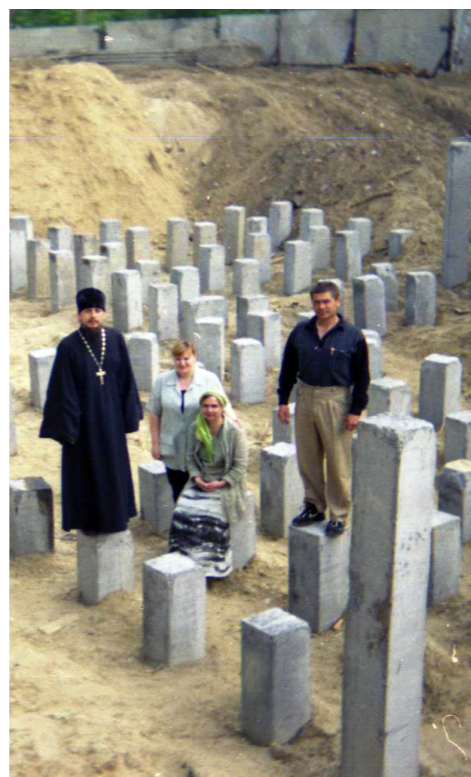
Строительство храма. Свайное поле. 2000 год.
