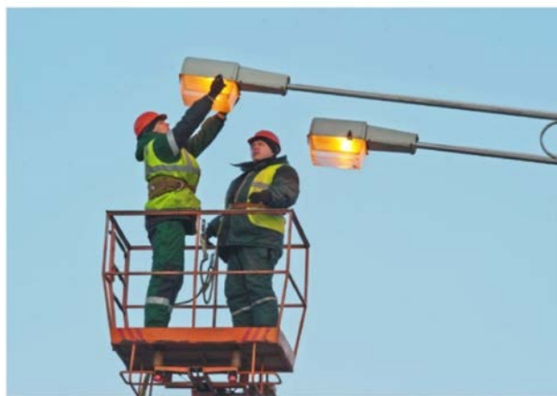
Обслуживание светильников уличного освещения
