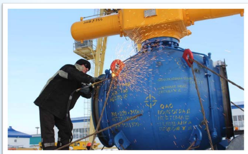
Срезка транспортировочных креплений
