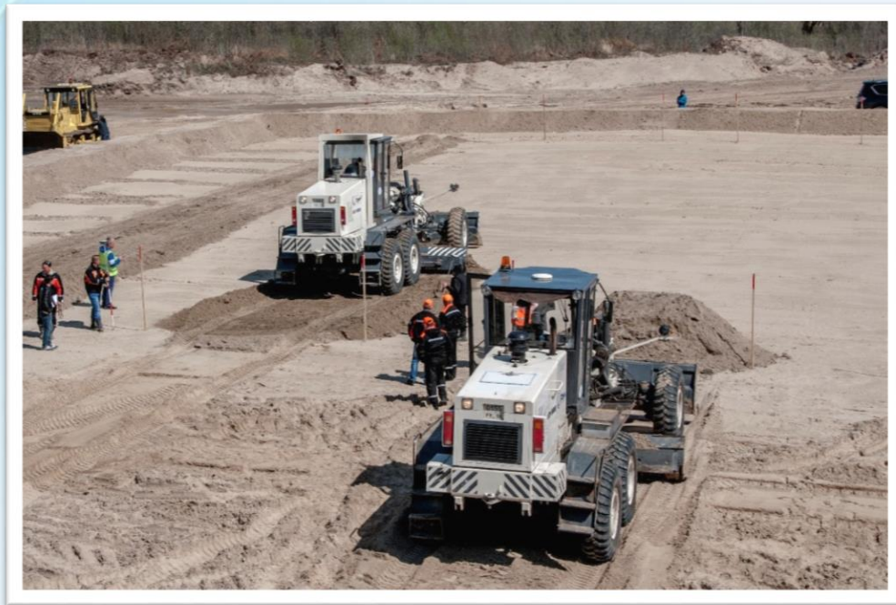
Машинисты автогрейдеров - осуществляют планировку грунтовой насыпи
