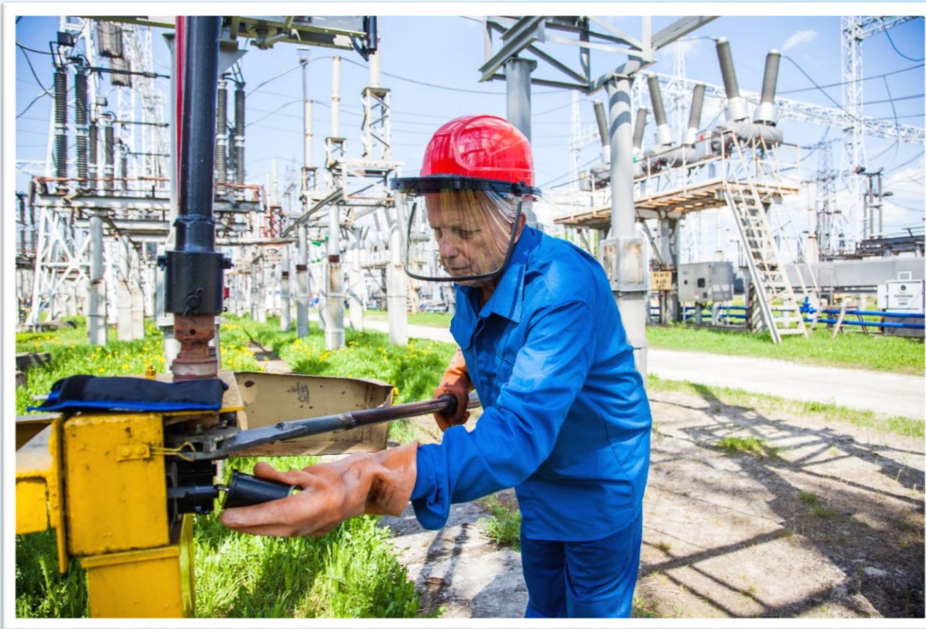
Операция включения заземляющего ножа
