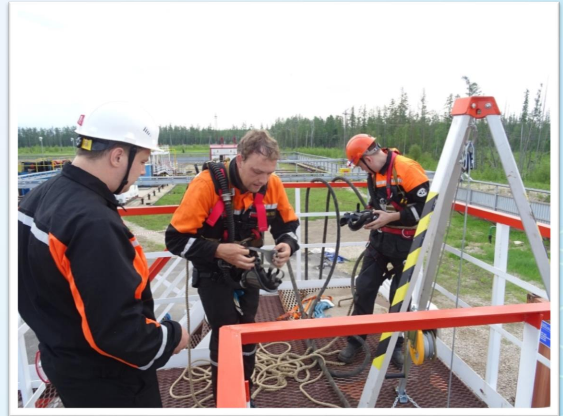
Перерыв в проведении газоопасных работ
