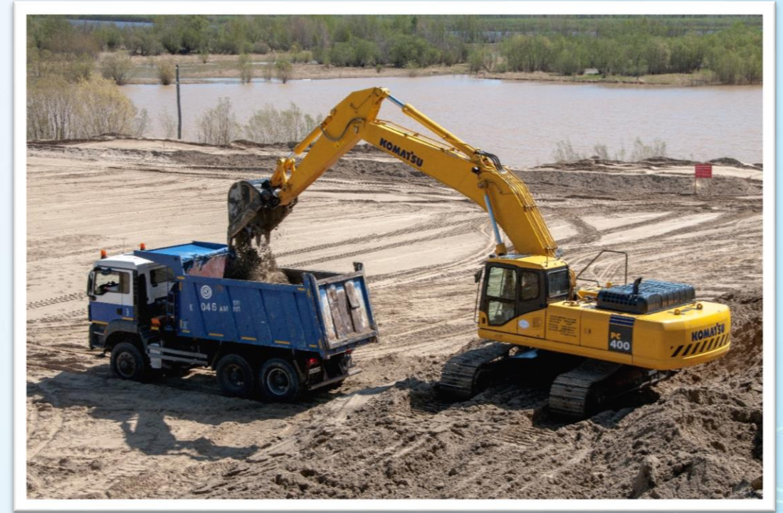
Машинист экскаватора – осуществляет погрузку грунта
