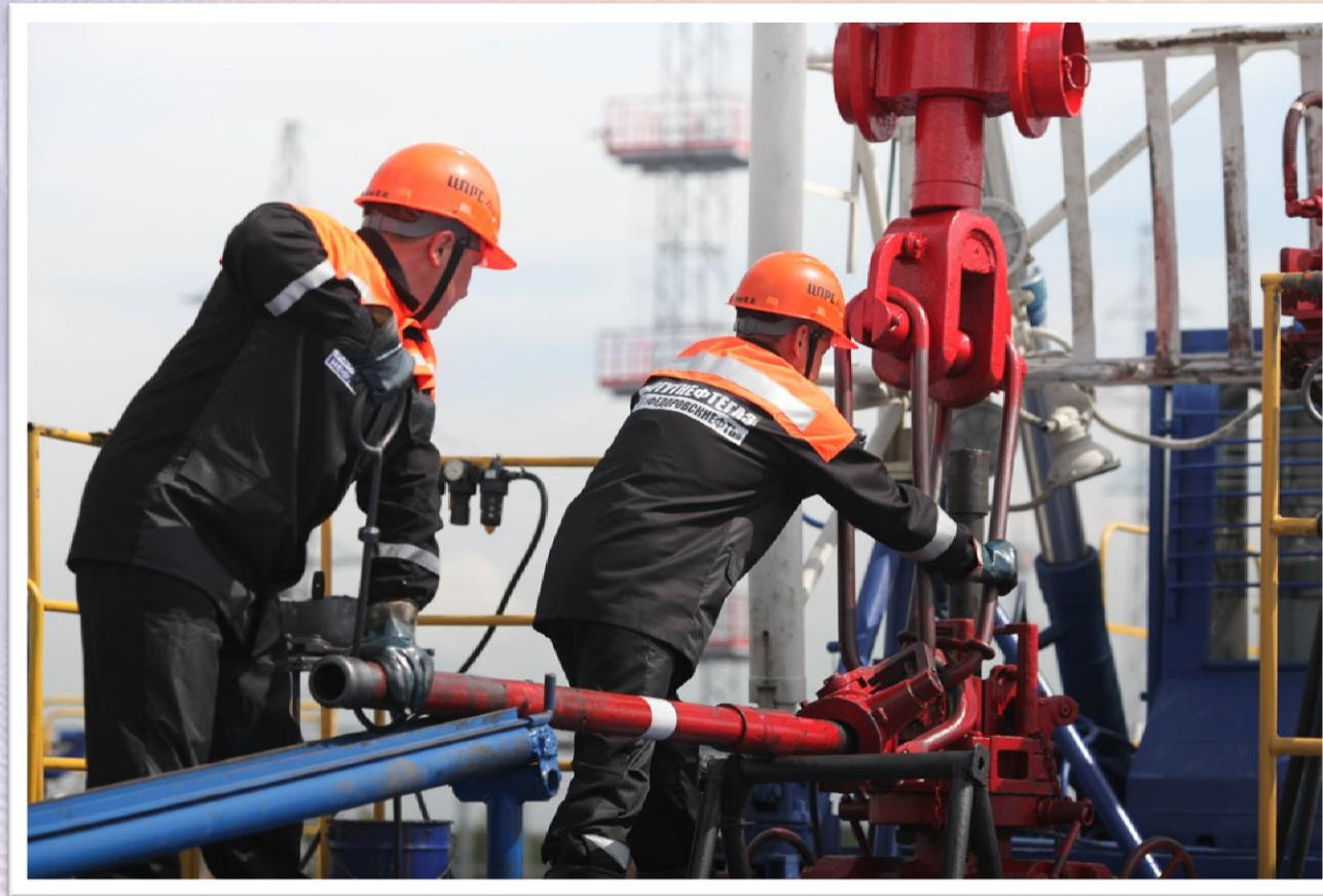
«Установка запорной компоновки»
