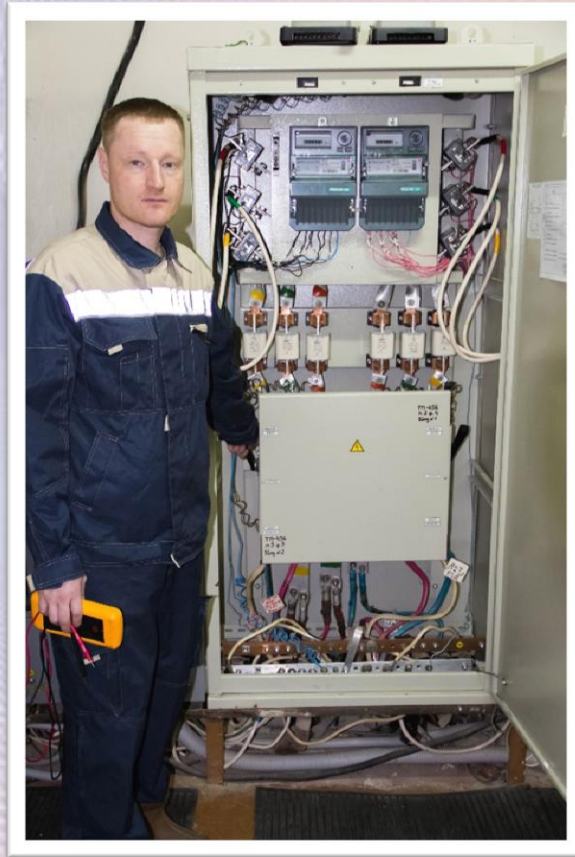
Электромонтёр по ремонту и обслуживанию электрооборудования
